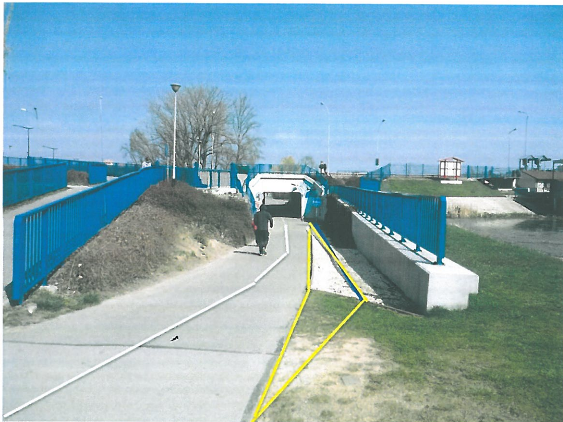
Rysunek 10. W nawiązaniu do interpelacji z dnia 12.04.2019r. ponawiam wniosek o likwidację kamyczków (są niebezpieczne dla rolkarzy) oraz o skromne poszerzenie tego krótkiego wąskiego odcinka, nawet za pomocą niefazowanej kostki brukowej, choć lepszy byłby asfalt. W tym miejscu dochodzi do konfliktów, sugeruję też na całości utrzymać separację ruchu linią ciągłą. Przycięcia wymaga również zieleni.
